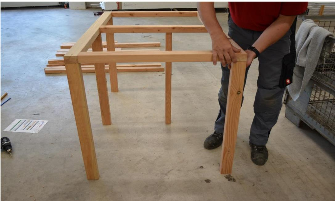
Anschließend drehen Sie die Konstruktion um und befestigen den 2. langen Rahmen mit der restlichen Konstruktion. Die Verschraubung erfolgt genau gleich wie oben beschrieben.
