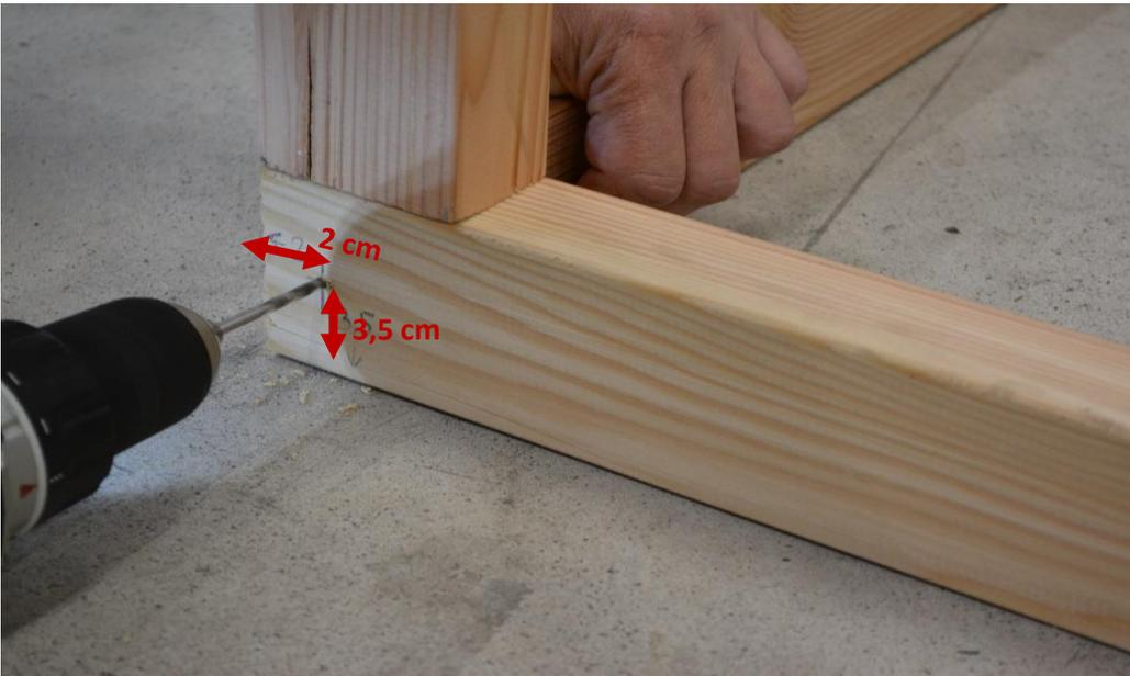
In der Mitte wird eine Querstrebe unten bündig zum Rahmen festgeschraubt.
