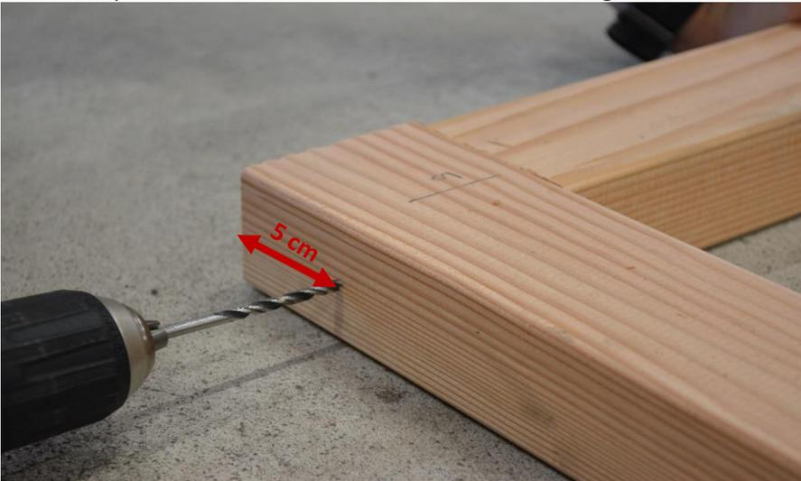
Die Schrauben der mittleren Unterkonstruktionsstange werden nicht mittig platziert, da später die Schrauben der Verkleidung mittig angebracht werden sollten.
