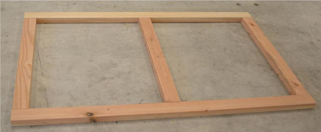
Zum Verbinden der Hölzer verwenden Sie die Schraube 6 mm x 80 mm.
